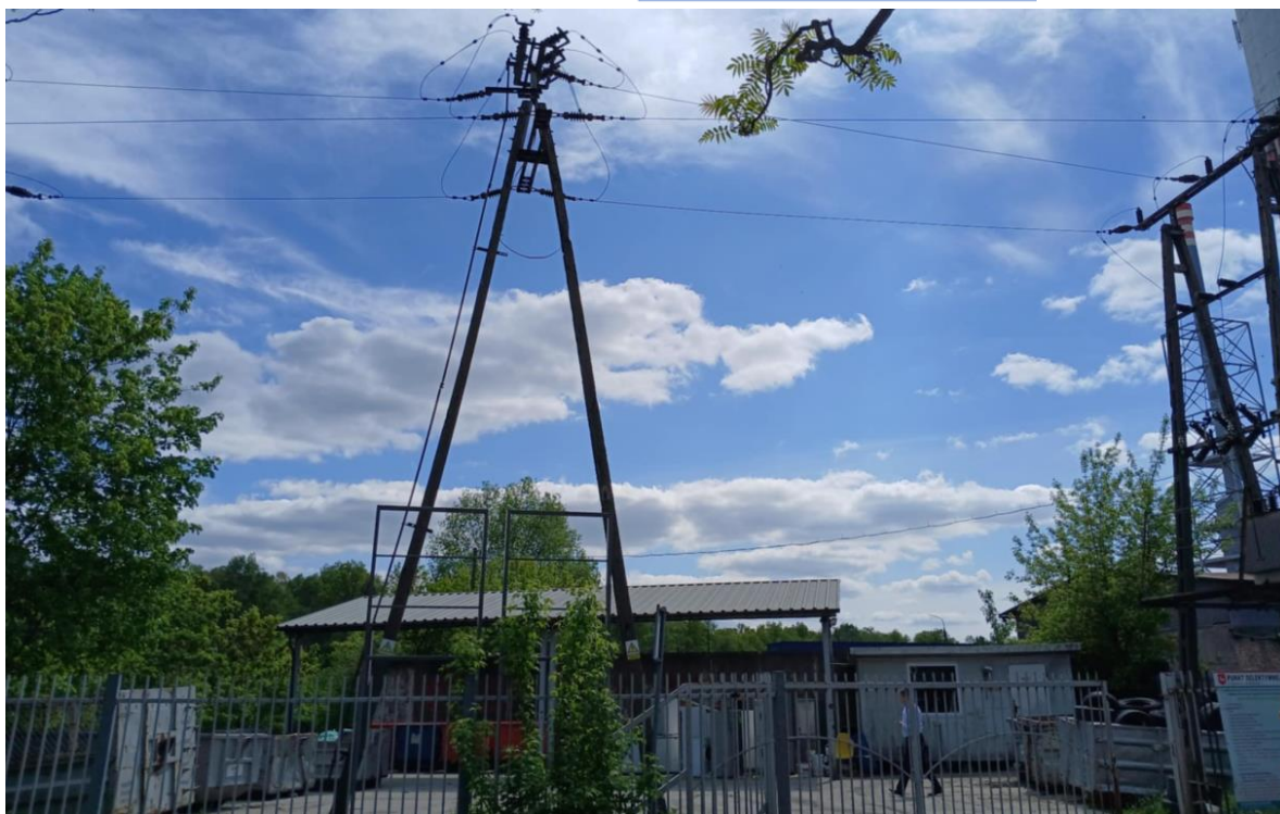
Fot. 3. Widok istniejącego terenu PSZOK wraz z wiatą i kontenerem socjalno-biurowym wraz ze słupami i liniami średniego napięcia Źródło: fotografia własna
