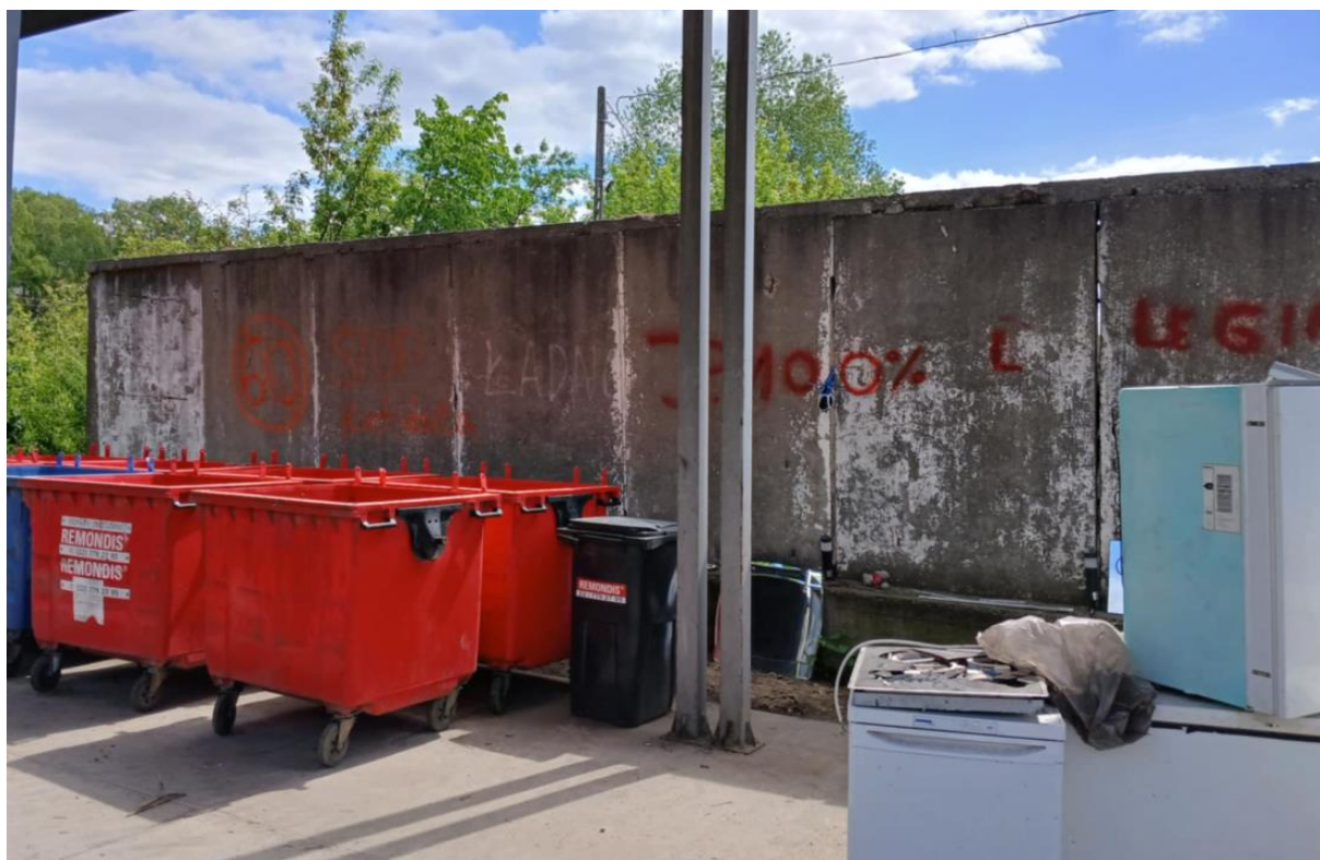
Fot. 4. Widok ściany/muru oporowego oddzielającego istniejący PSZOK od firmy Remondis Źródło: fotografia własna
