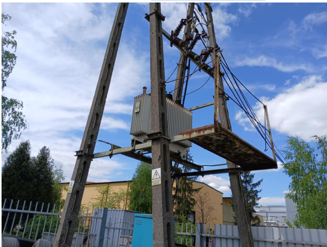
Fot. 1. Isniejąca trafostacja. Źródło: fotografia własna
